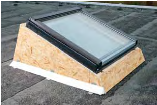
Sklon okna ve zdvihovém rámu je zvýšen o bezpečných 20° proti zatékání.
